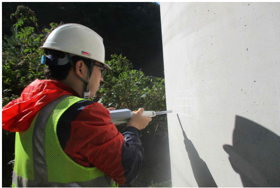
교각 압축강도 측정①
