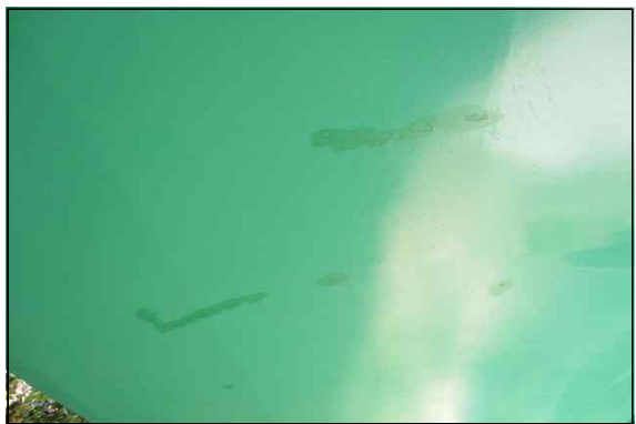
거더 외부 도장손상 보수(S1-G1)
