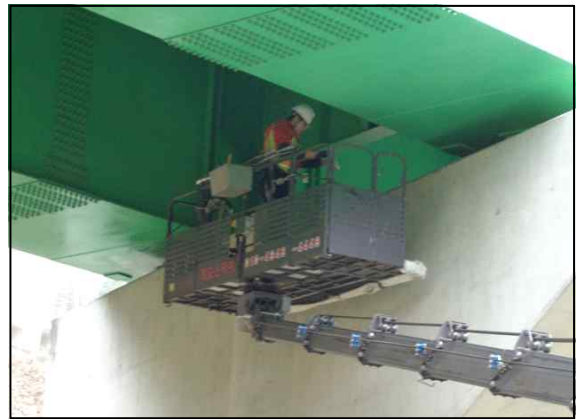
작업차량을 이용한 외관조사
