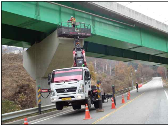
작업차량을 이용한 외관조사
