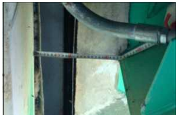
신축이음 하부 유간측정 현황(A2)
