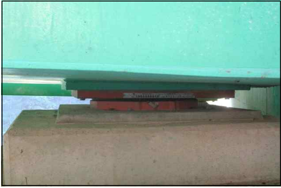
받침 전경(A1 SH1)
