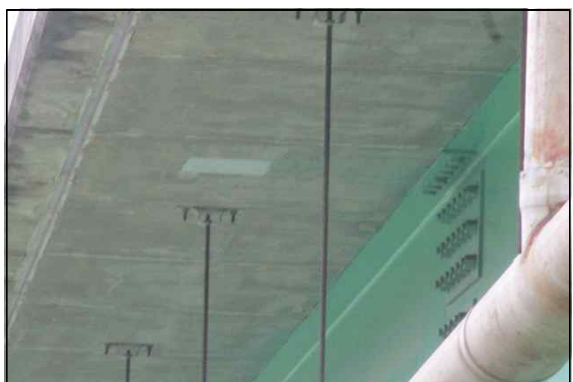
바닥판 파손 보수(S2) - 금회
