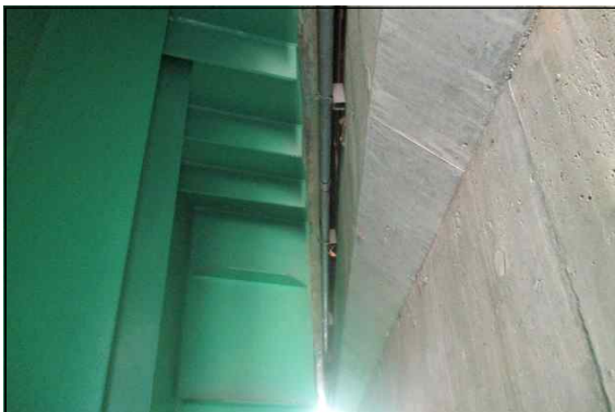
신축이음 하부 유간측정 현황(A1)
