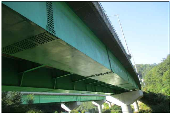
거더 외부 전경
